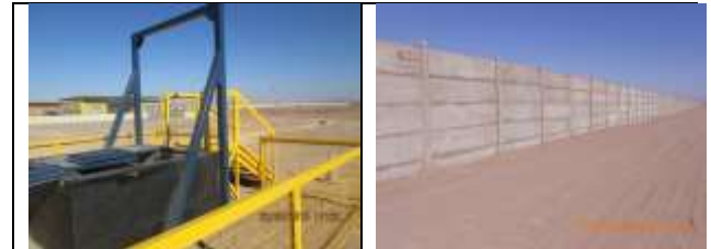
Mejora del Estanque de Agua.
